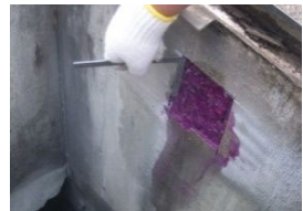
コンクリート劣化調査
