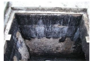
コンクリート調査
