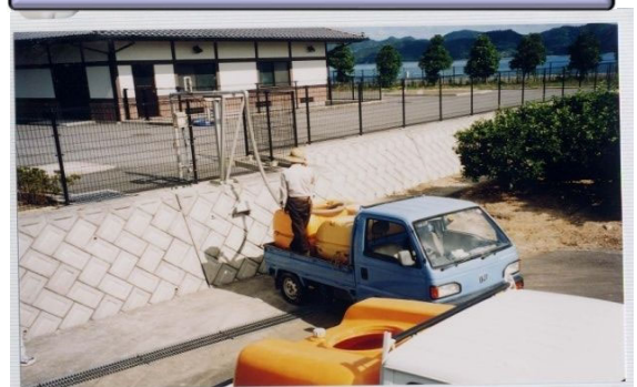
取水スタンド(処理施設)
