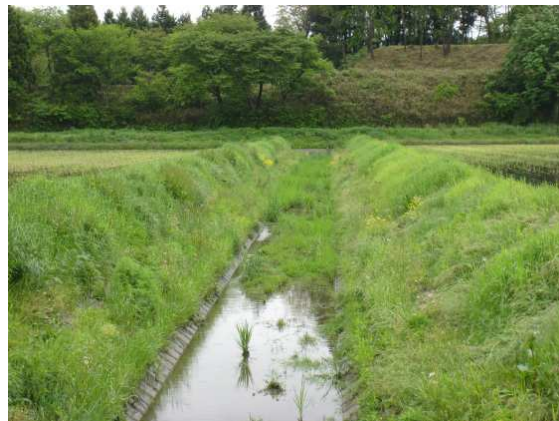
施工5年後の幹線排水路
