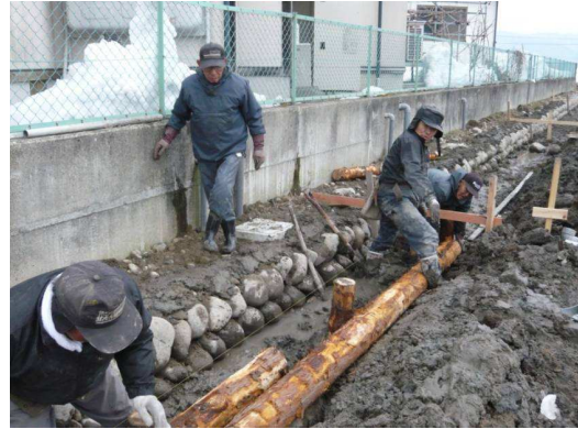
事例：山形県元泉地区（以下、「元」）水路周辺整備
