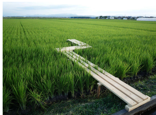
写真6 仮設の木道を設置 直営施工で得たノウハウで住民自らが資材を購入し、設置した仮設の観察用木道（元）
