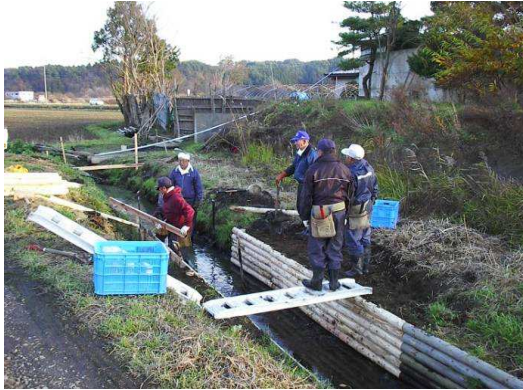
事例：青森県外黒山地区（以下、「外」）水路改修
