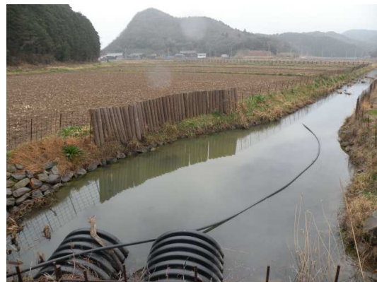
排水路護岸の侵食やほ場への排水流入を防ぐために地域住民によって設置された木柵
