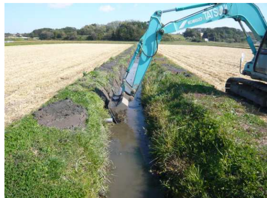
生態系保全水路(土水路)の泥浚いは、路床を気にせず重機のみで作業が可能。
