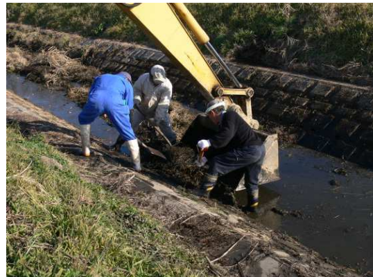
パネル上の泥をバケットですくうには細心の注意が必要。写真では路床のパネルを傷めないよう、人力でバケットに泥を集めている。
