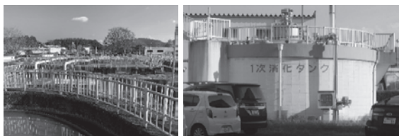
写真2 A施設の水処理施設及び一次汚泥消化槽
