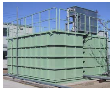
改築工事施工中に使用する 「仮設膜処理設備」
