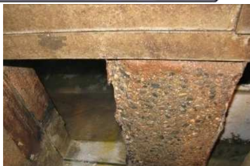
コンクリートの粗骨材の露出、部分的な剥離
