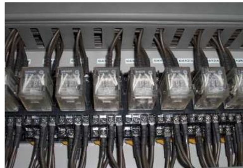
盤内のケーブルや接点の変色・劣化
