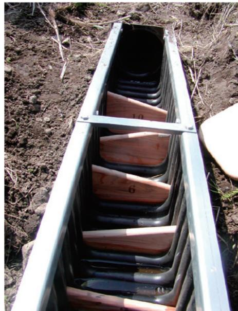
水田水位調整用堰板の挿入状況
