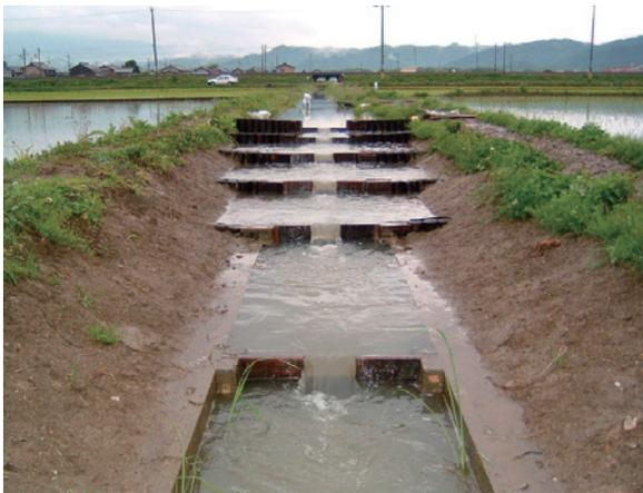
写真6 ③切り欠き型の水田魚道(滋賀県琵琶湖畔)
