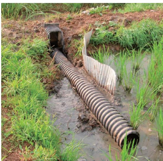
写真三 落水口と波付の丸型の接続
