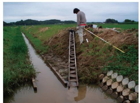
三面装工で取り付け部を拡幅した場合
