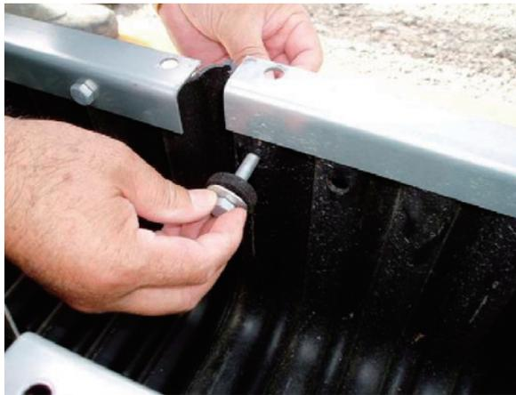
波付の U 型の側面をボルトで固定する
