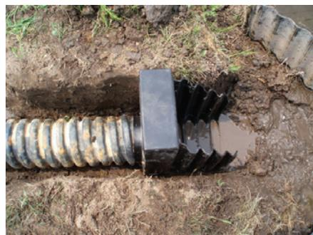
落水口と波付の丸型の接続
