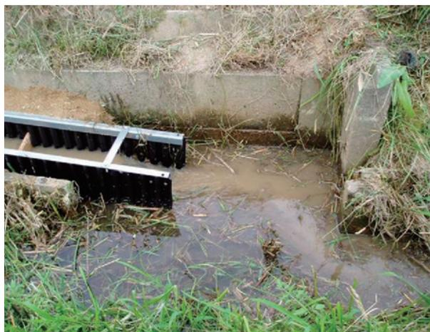
組立柵渠の側板を取外し拡幅した事例
