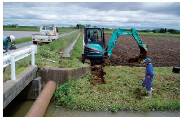
ミニバックホウ (掘削土量が多い場合)
