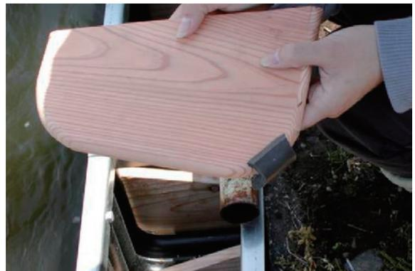
堰板と漏水補強
