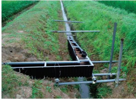
波付のU型（180型）可動式タイプ 設置勾配12° 斜長 L=6.12m
