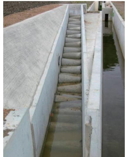
写真5 ②ハーフコーン型の水田魚道
