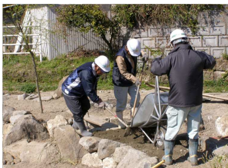
ビオトープの遊歩道造成（鹿児島県土連）
