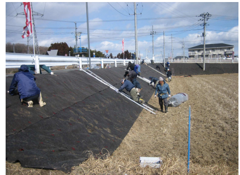
法面のカバープランツ植栽（宮城県土連）
