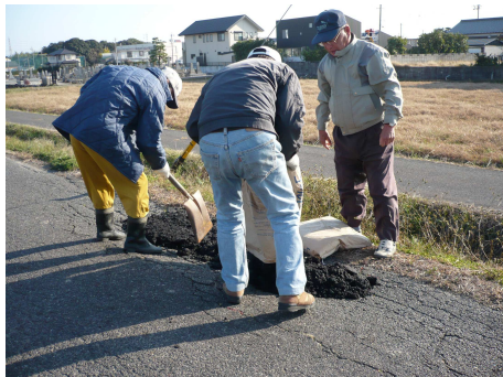
農道のアスファルト補修（愛知県土連）
