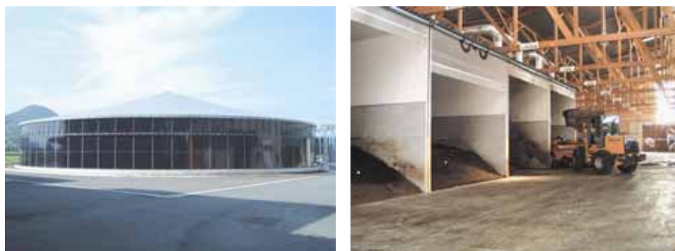
写真 3-2 液肥貯留槽 (左) たい肥製造施設 (右)
