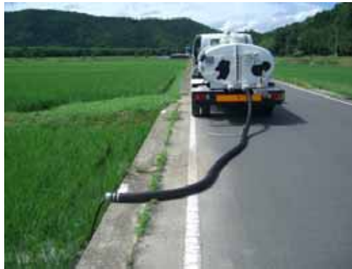
写真 5-5 バキュームローリーによる流し込み
