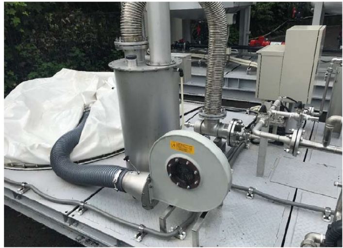
写真 6. 2. 11 左 : ガスホルダー、右 : 緊急ガス放流
