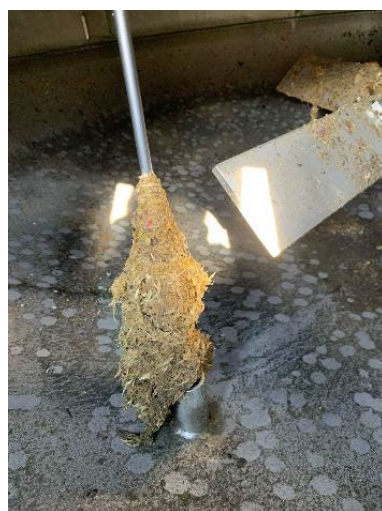
写真 6.2.20 水位計に付着したゆず繊維
