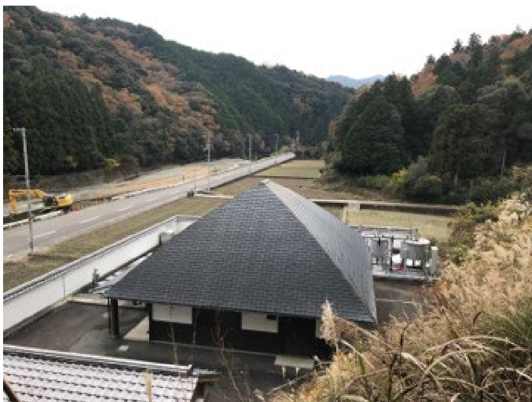
写真 6. 2. 17 実証施設遠景
