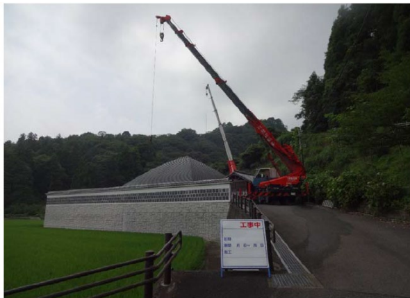
写真 6.2.1 集排施設全景
