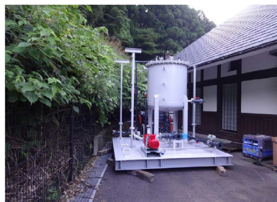
写真 6.2.6 混合調整槽仮据え付け
