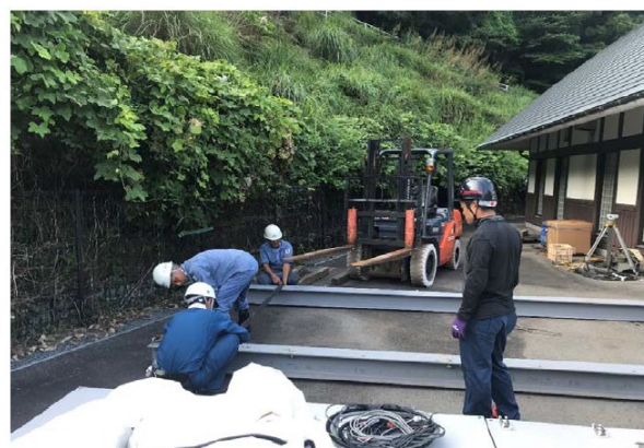
写真 6.2.4 ベース用桁設置
