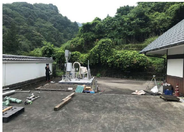
写真 6.2.2 設置場所全景
