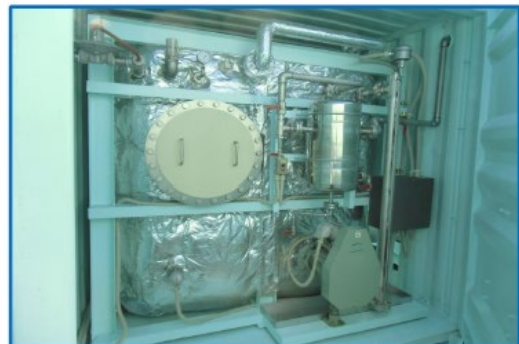
写真 6.7.2 メタン発酵施設設置状況
