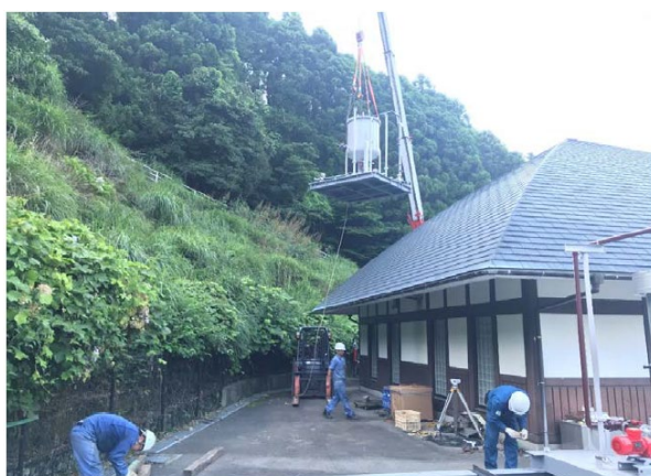
写真 6.2.5 混合調整槽吊り込み
