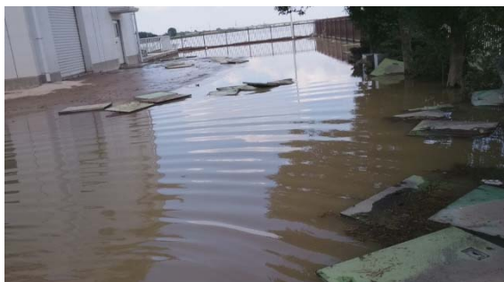
処理水槽点検蓋の流出
