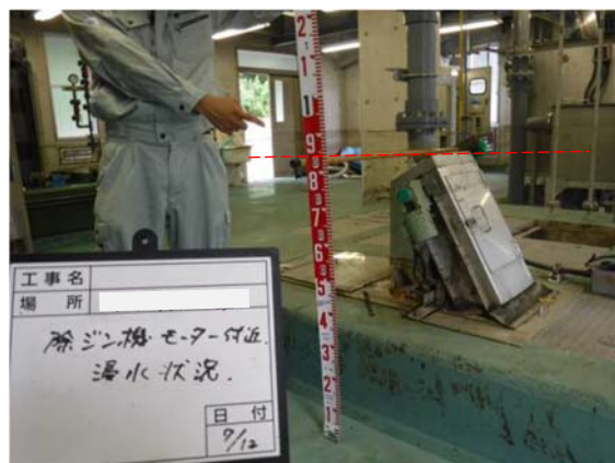
自動荒目スクリーンの浸水
