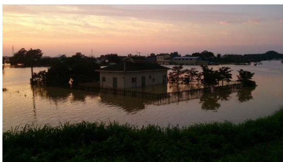
污水处理施設の浸水
