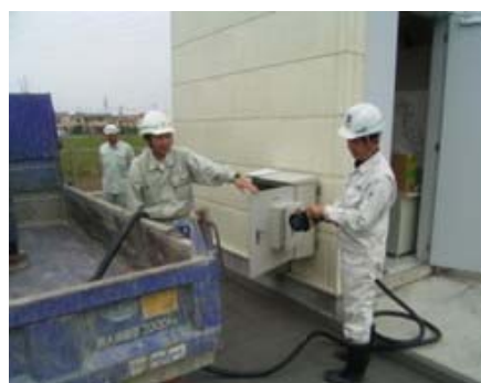
写真－6－8 左：非常用発電設備、右：外部電源用の非常電源受電盤
