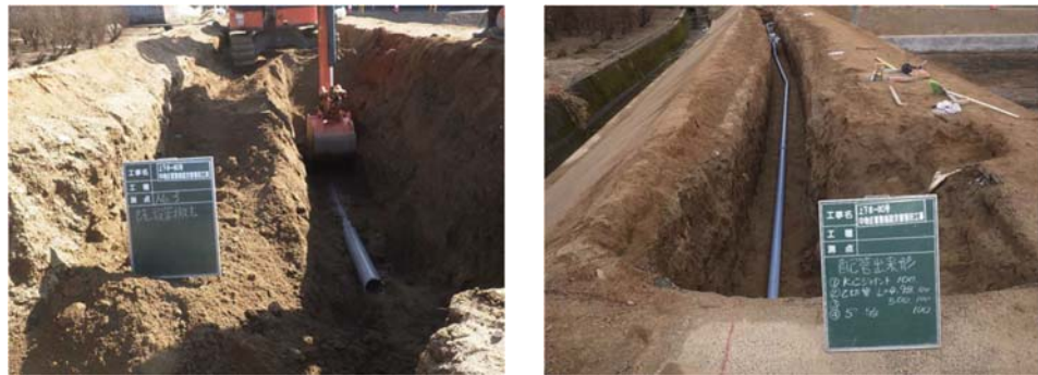
写真-4-9 左：仮復旧管（RR管）の撤去、右：真空用塩化ビニル管での本復旧
