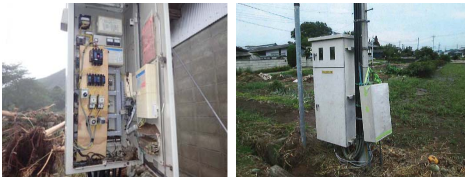
写真－４－６ 仮設盤による応急復旧 (左：被災していない部品を活用、右：備蓄仮設盤を活用)
