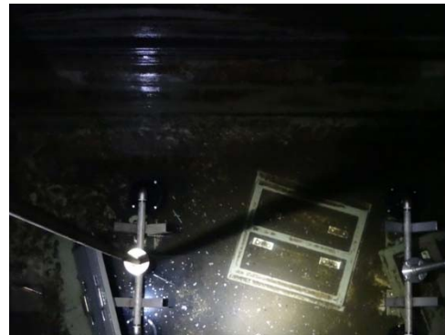
写真－５－７ 左：流量調整槽の土砂混入（汚水計量槽の四角堰） 右：水槽内への覆蓋の落下（汚泥貯留槽）
