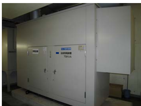
写真－6－8 左：非常用発電設備、右：外部電源用の非常電源受電盤
