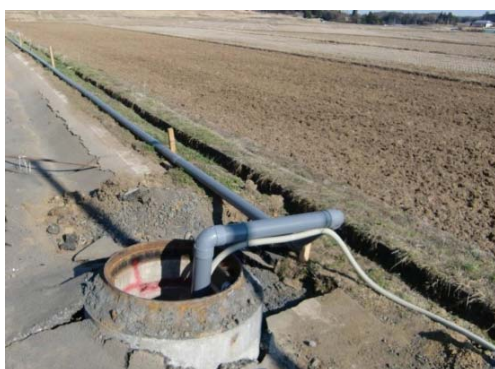
写真－４－４ 仮設配管・仮設ポンプによる応急復旧（地震時の例）
