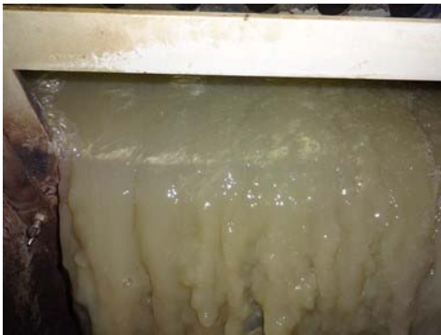
写真－５－７ 左：流量調整槽の土砂混入（汚水計量槽の四角堰） 右：水槽内への覆蓋の落下（汚泥貯留槽）
