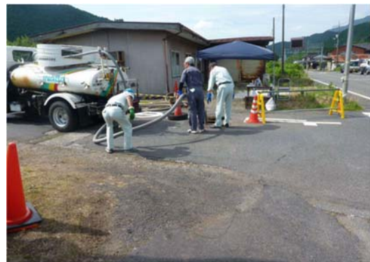
写真－３－８ 中継ポンプ施設被災時の汚水の引抜き状況
