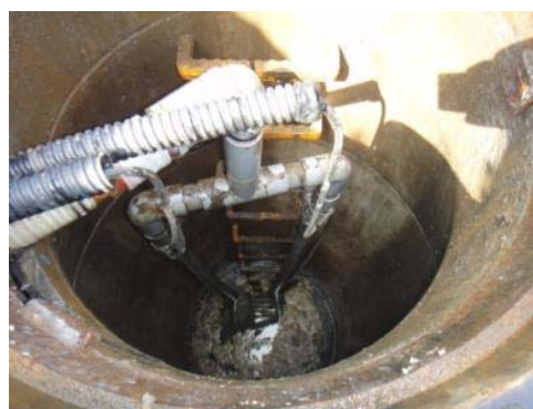
写真－４－４ 仮設配管・仮設ポンプによる応急復旧（地震時の例）
