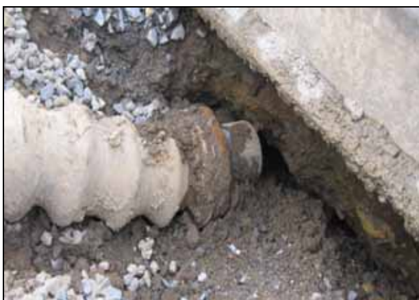
写真 - 3 地震動（液状化現象）による流入管等の破損（東北地方太平洋沖地震）
