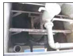
導入前の汚泥濃縮槽内部
