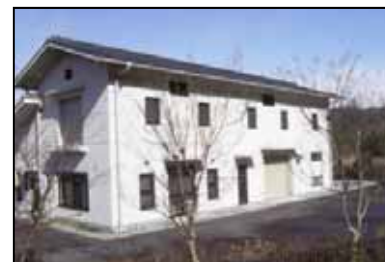
貝野瀬・生越処理施設の建屋
