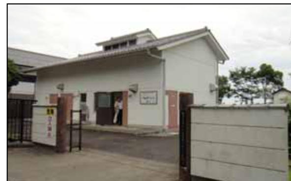
砂川処理施設の建屋
