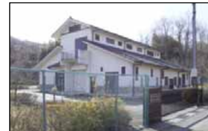
糸井・三ツ谷処理施設の建屋
