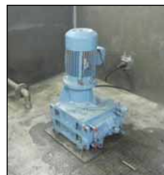
ばっ気攪拌装置の回転数の段階的回転調整
