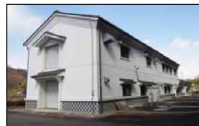
昭和南処理施設の建屋
