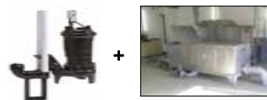
汚水計量槽の調整、流量調整ポンプの運転時間調整
