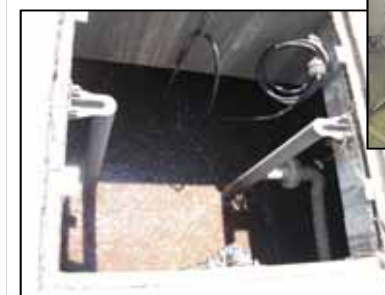
ばっ気攪拌装置及び ばっ気ブロワの運転調整
