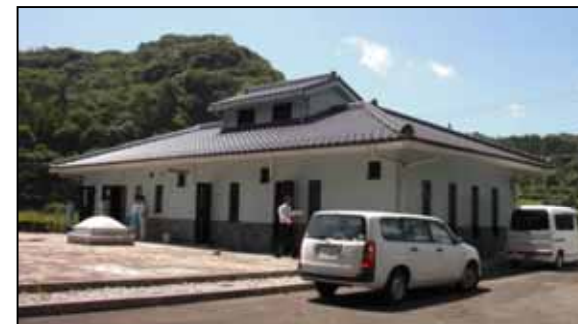
吉部排水処理施設の建屋
