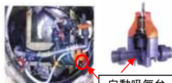
真空管路吸気弁
