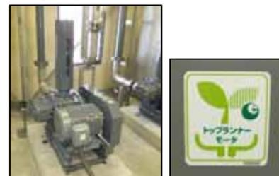
トプラナーモータ搭載型プロワ (設置のイメージ)
