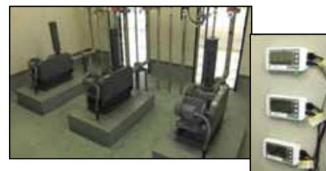
ばっ気プロワ 電力量計設置状況
