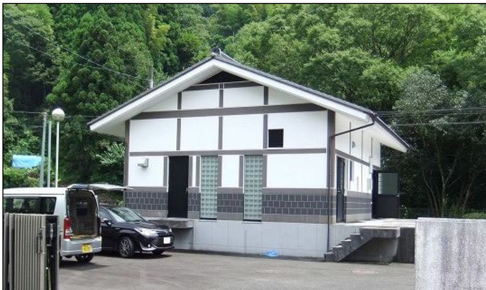
写真 3.12.1 地蔵寺処理施設の全景
