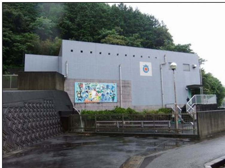
写真 3.14.3 宮前地区処理施設の全景
