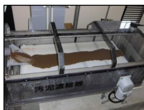
汚泥の投入状況
