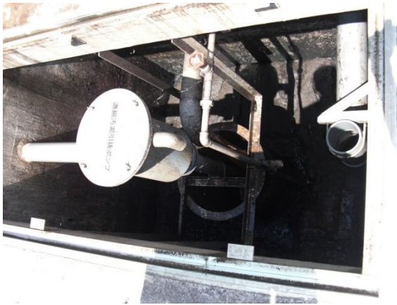
汚泥濃縮装置導入前の汚泥濃縮槽内部
