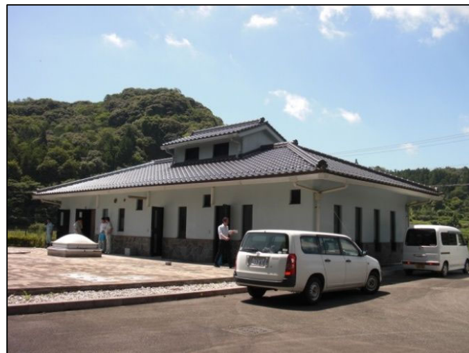
写真 3.4.2 吉部排水処理場の全景
