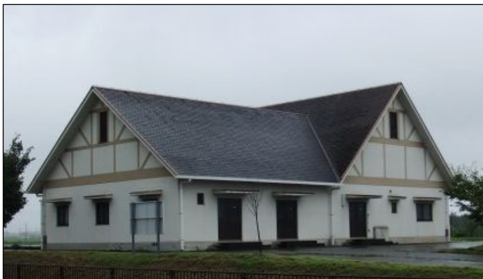
写真 3.5.1 駒衣地区の処理施設の全景
