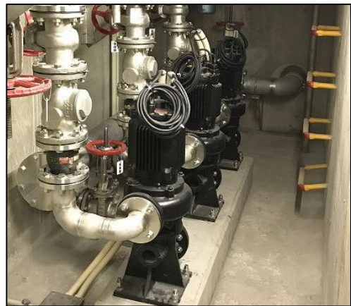
縦型槽外式汚水汚物ポンプ（1.5 kW）
