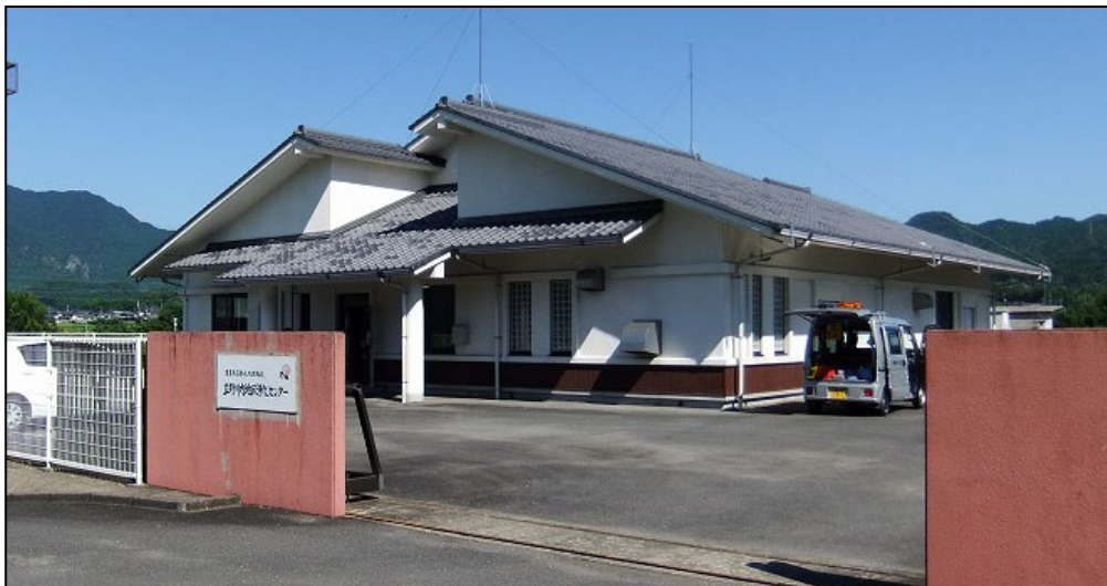
写真 3.3.1 立野川内地区浄化センターの全景
