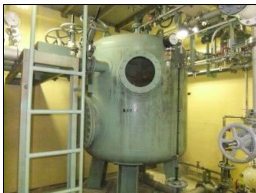
集水タンク（既存施設）
