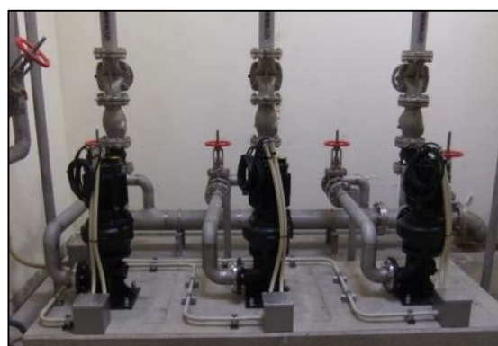
写真 3.5.3 堅型槽外式汚水汚物ポンプの写真
