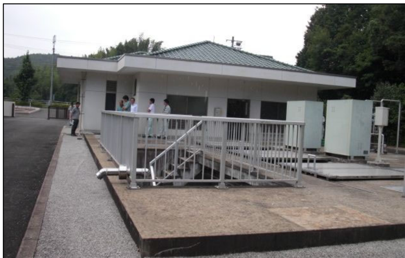
写真 3.15.1 花香地区処理施設の全景
