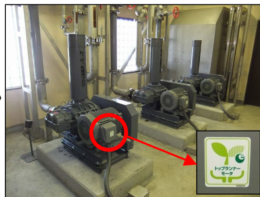
トップランナーモータ搭載型のばっ気槽ブロワ
