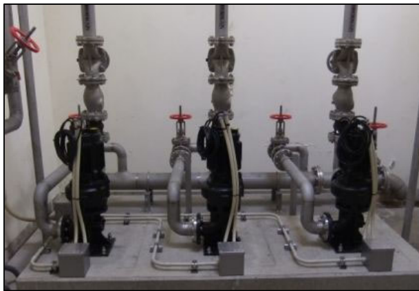
写真 3.16.1 汚泥引抜ポンプ及び稼働時間の制御機器
