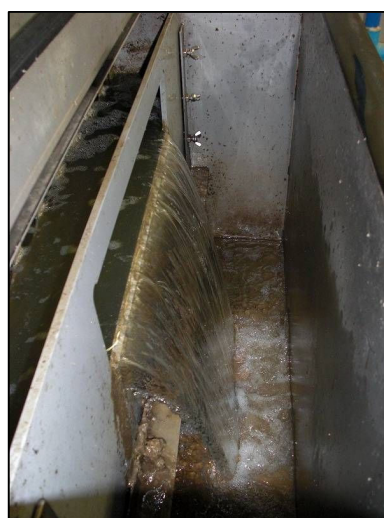
汚水計量槽の四角堰の状況
