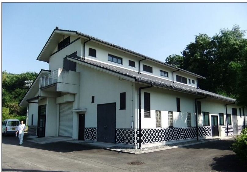
写真 3.13.4 糸井・三ツ谷地区処理施設の全景
