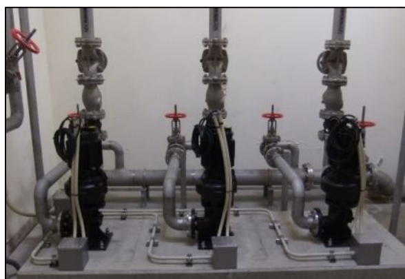
写真 3. 16. 3 汚泥引抜ポンプ及び運転時間の設定状況 (縦型槽外式汚水汚物ポンプ)
