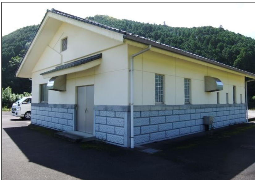
写真 3.6.1 奈路地区農業集落排水処理施設の全景
