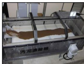
汚泥の投入状況
