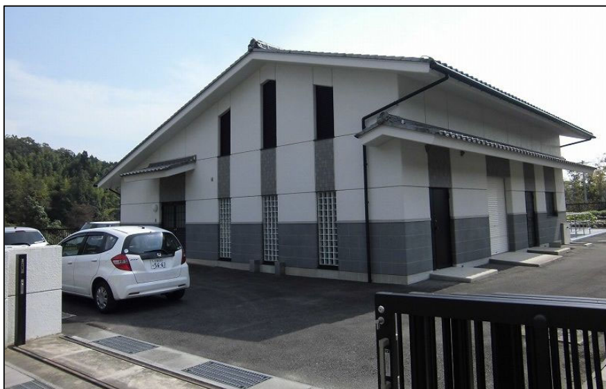
写真 3.11.1 西山地区集落排水処理場の全景
