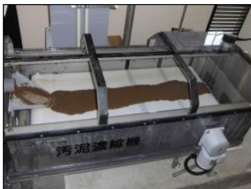
汚泥の投入状況 （上部カバーを外して撮影）
