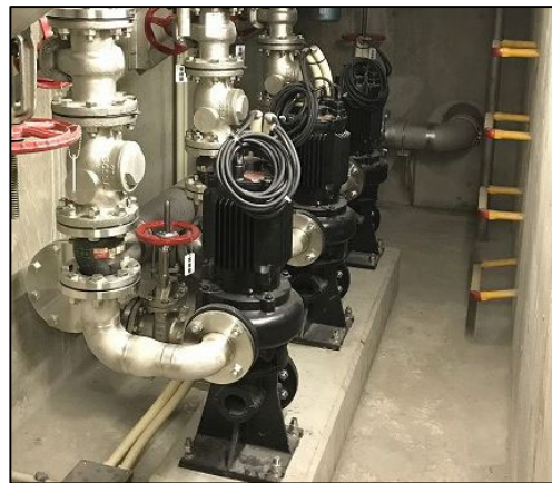
縦型槽外式汚水汚物ポンプ（1.5 kW）
