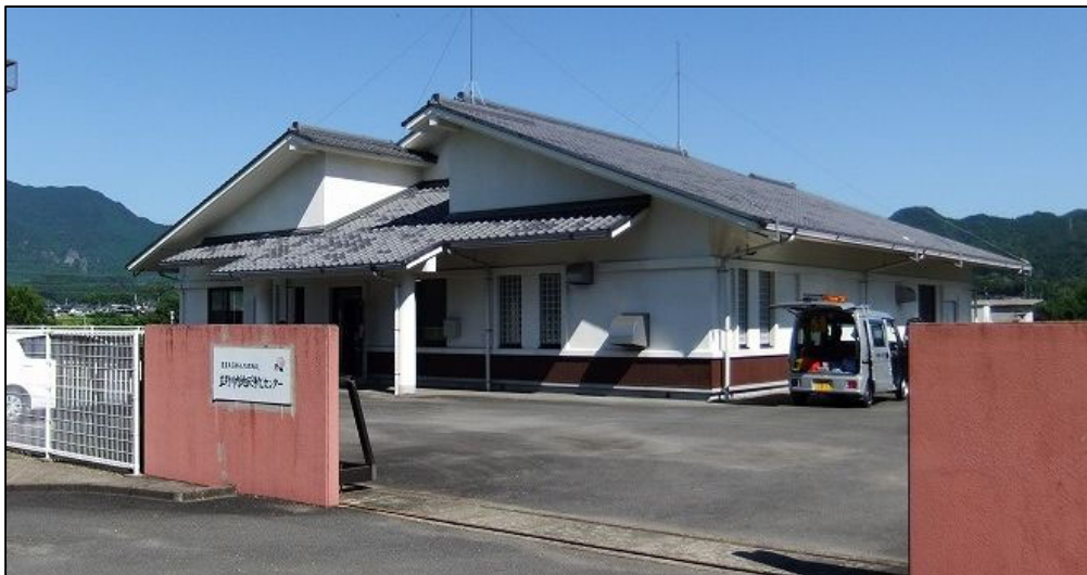
写真 3.3.1 立野川内地区浄化センターの全景
