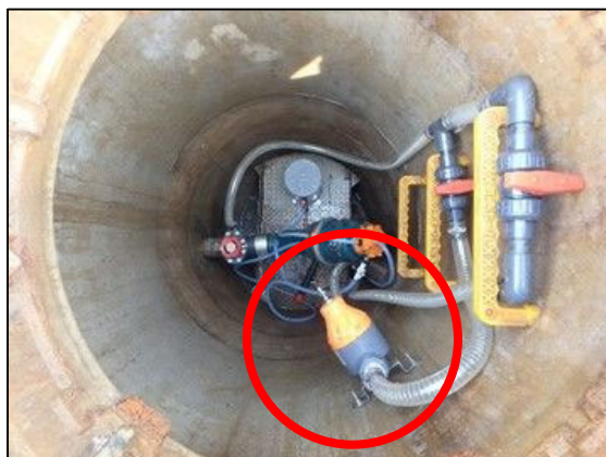
写真 3.7.3 自動吸気弁の設置状況の写真
