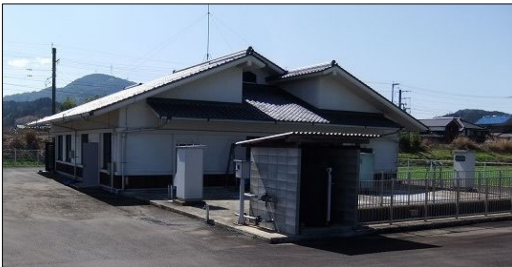
写真 3.10.1 三間坂地区処理施設の全景
