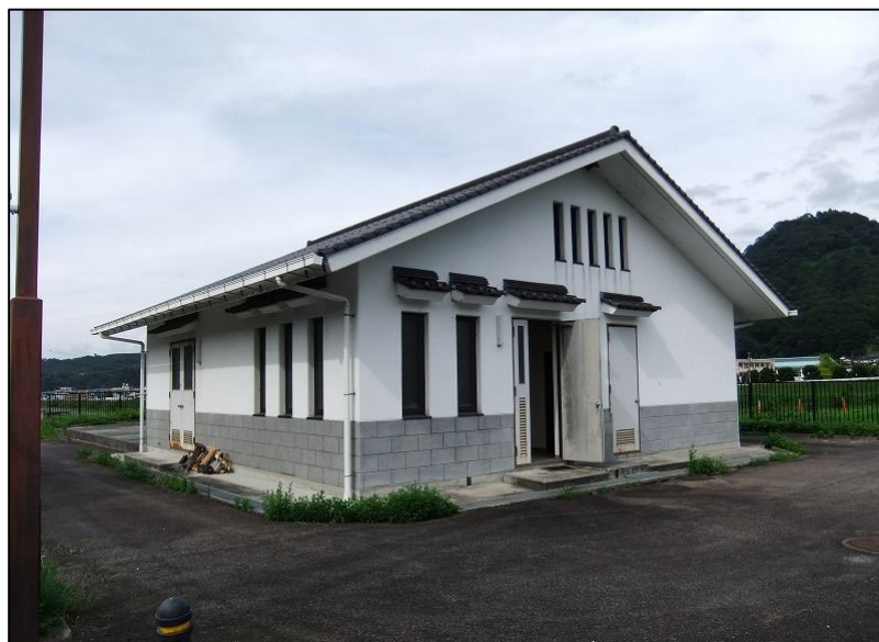
写真 3.2.1 旭地区処理施設の全景
