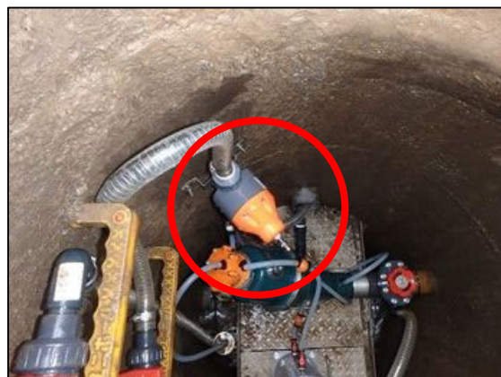
写真 3.7.3 自動吸気弁の設置状況の写真
