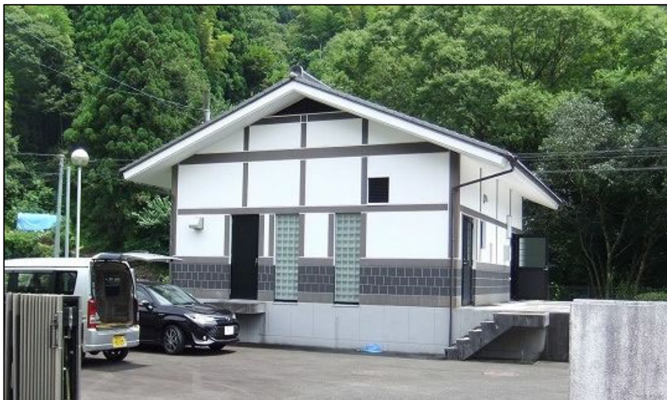
写真 3.12.1 地蔵寺処理施設の全景
