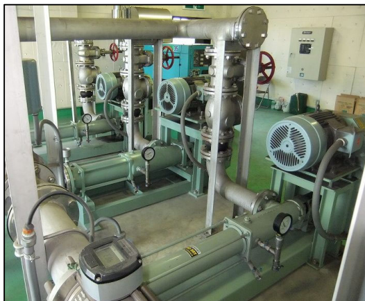
自吸式一軸ネジ式汚泥引抜ポンプ（11 kW）
