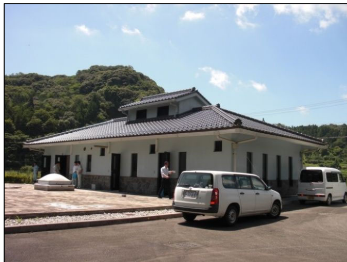
写真 3.4.2 吉部排水処理場の全景
