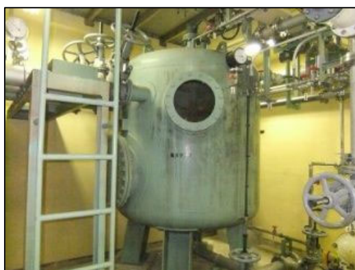
集水タンク（既存施設）
