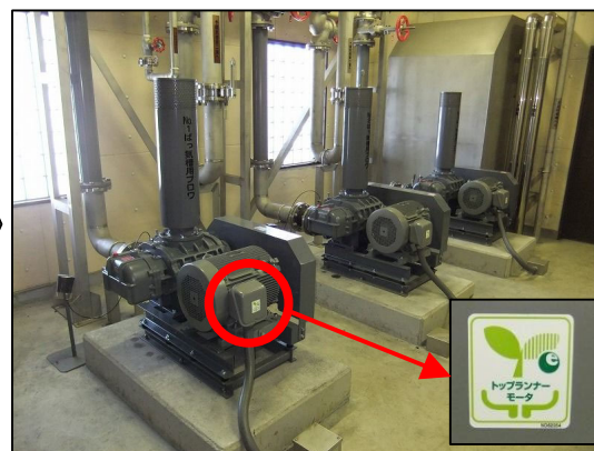
トッランナーモータ搭載型のばっ気槽ブロワ
