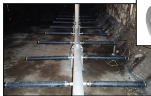
微細気泡散気装置
