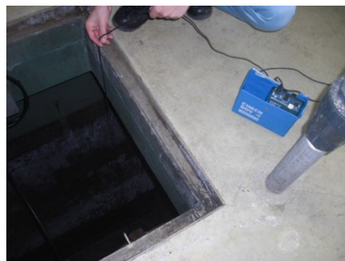
写真3-6-4 流量調整槽底部の流入SS堆積厚調査状況
