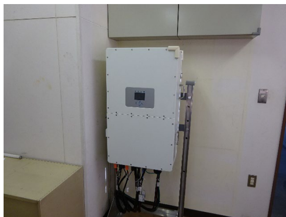
写真 1-2-2 三相 PCS(パワーコンディショナ) (太田市毛里田北地区)
