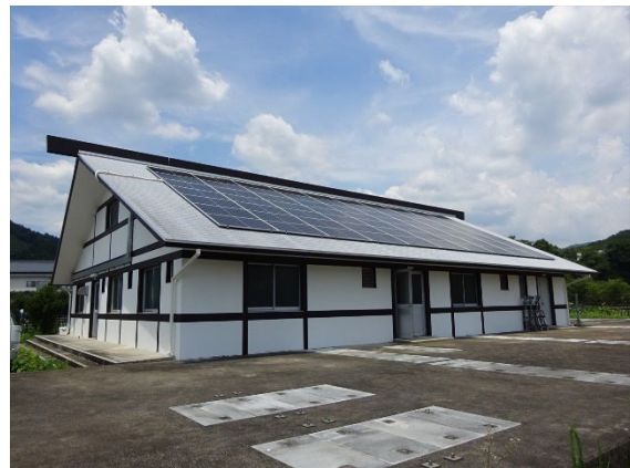
写真 1-2-8 単相蓄電池システム (岡崎市豊南地区)
