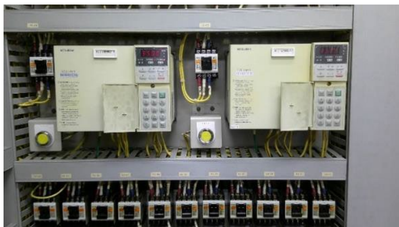
写真 3-6-13 共用ブロワのインバーター調整（50Hz→35Hz にセット）
