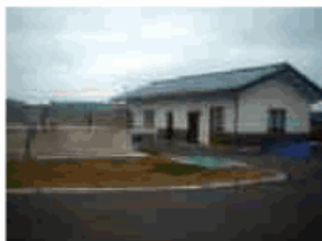
写真-3 所要室は、管理室、ブロワ室、脱臭設備コーナー、機材倉庫、便所により構成している。また、のべ床面積は84.5㎡(730人規模)と抑えられている。
