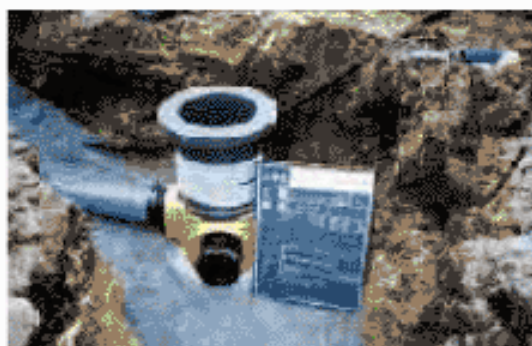
レジンマンホール布設状況
