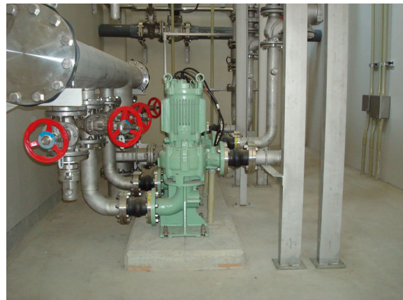
写真 3-5-2 返送汚泥ポンプに縦型汚水汚物ポンプを採用した事例
