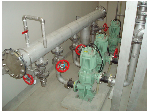
写真 3-5-2 返送汚泥ポンプに縦型汚水汚物ポンプを採用した事例
