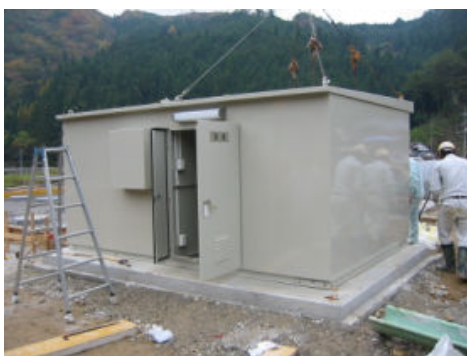
写真 3-2-1 鋼製ボックス型管理棟
