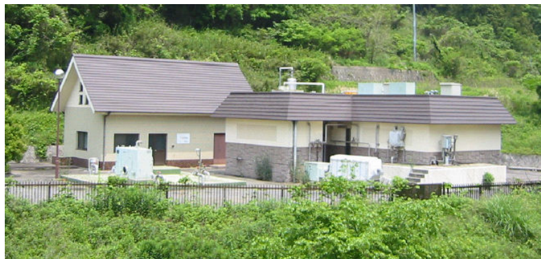
写真 3-1-2 水槽を地上式とした施設
