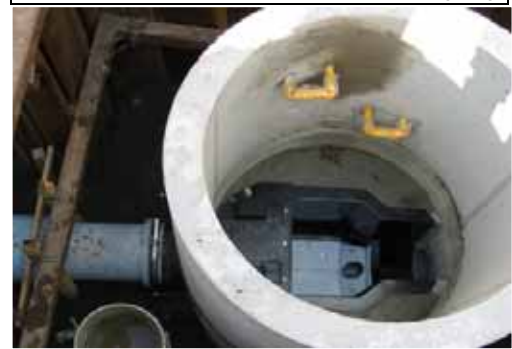
写真 2-2-2 減勢施設の施工状況
