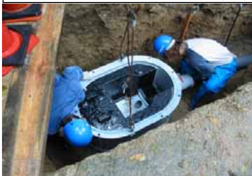
写真 2-2-2 減勢施設の施工状況
