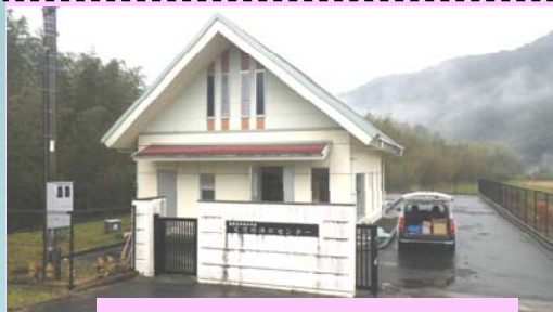
大河内地区農業集落排水施設
