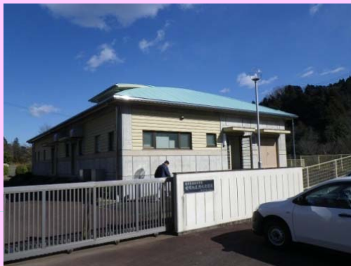
嵯峨地区農業集落排水施設
