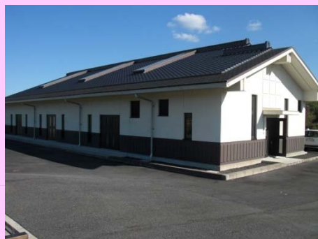
檜崎地区農業集落排水施設
