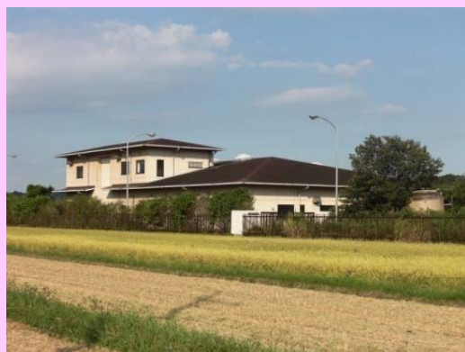
信太地区農業集落排水施設
