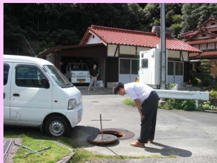
明木市地区中継ポンプ施設
