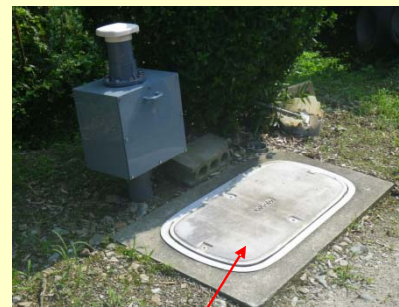
写真 自動吸気弁設置 状況写真
