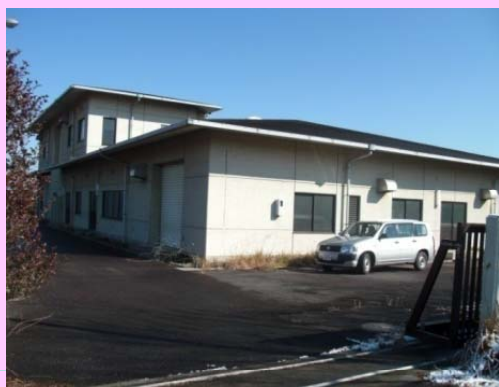
信太地区農業集落排水施設
