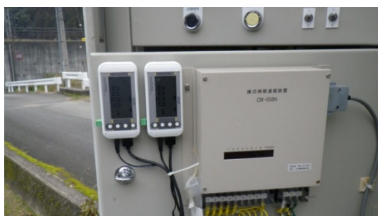
電力量計 設置
