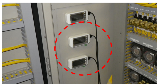
電力量計 設置
