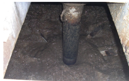
ばっ気攪拌装置：縦軸ロータ
