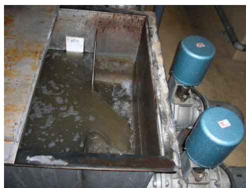
写真 5. 2. 2 汚水計量槽の戻し流量を抑えた状況
