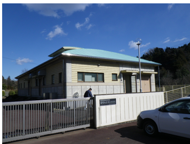
嵯峨地区処理場 全景
