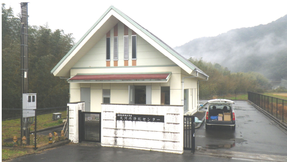
写真 4.4.2 大河内地区処理場 全景
