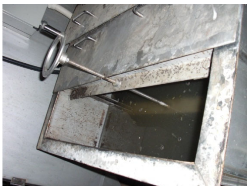
写真 5. 2. 2 汚水計量槽の戻し流量を抑えた状況
