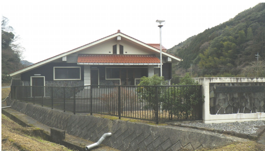
写真 4.4.1 佐々並市地区処理場 全景
