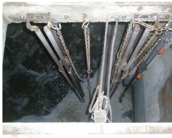
写真 5.1.4 信太地区の制御盤全景及び流量調整槽攪拌装置の全景
