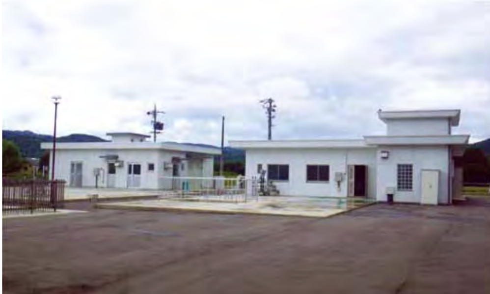
赤目南部地区処理施設（左側：既設 右側：新設）
