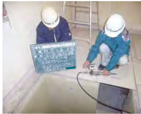
防食被覆工接着強度試験（1種）
