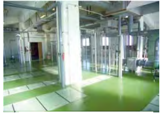
東鮎川処理場内（改築後）
