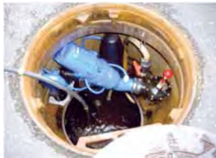
新型真空弁設置完了
