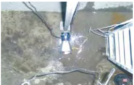
水中攪拌装置設置後
