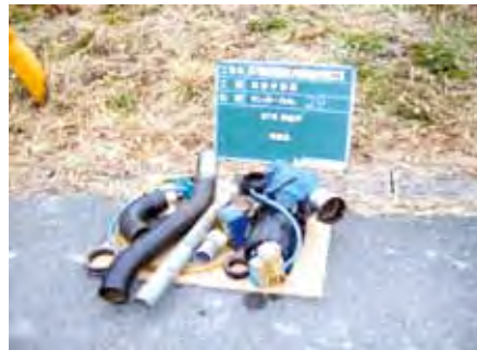
既設真空弁ユニット取り外し状況
