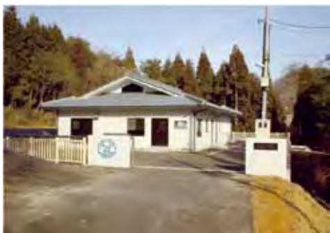
安養寺 処理施設
