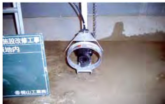
水中攪拌装置設置後
