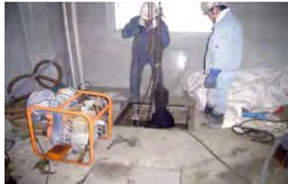
攪拌ポンプ撤去中
