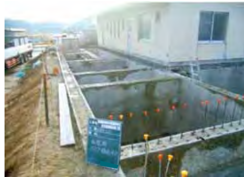
既設スラブ撤去
