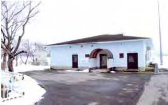
全景（東鮎川処理場）
