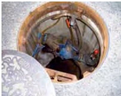
着工前 真空弁ユニット
