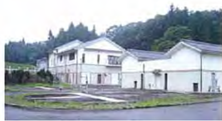
山手地区 汚水処理施設 (OD方式 4,550人)
