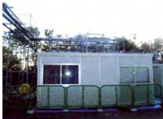
②仮設処理設備設置状況
