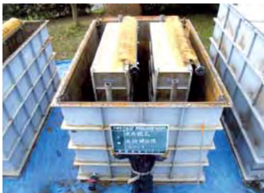
①仮設膜ユニット
