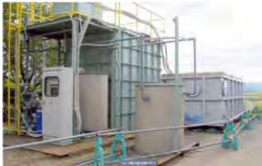
仮設膜ユニット設置状況
