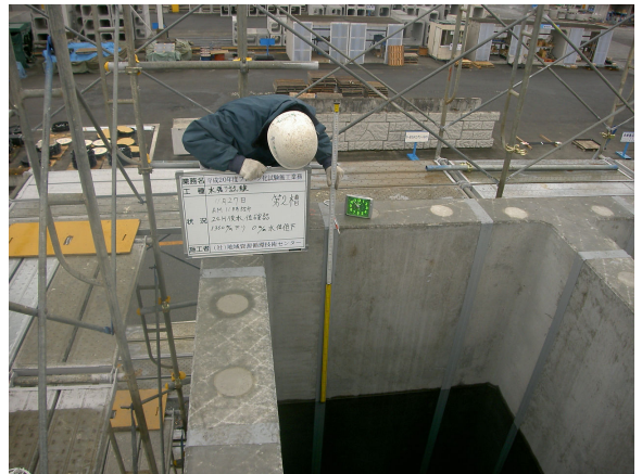
⑨ 水張試験工
