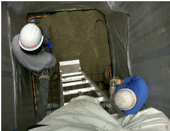
⑧ 底版コンクリート打設工
