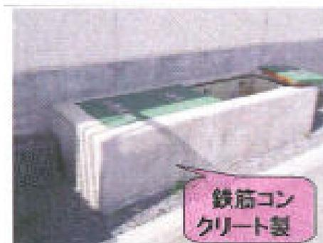
写真 11-1 RC 製の汚水計量槽
