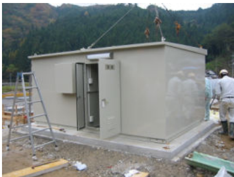
写真 3-2-1 鋼製ボックス型管理棟
