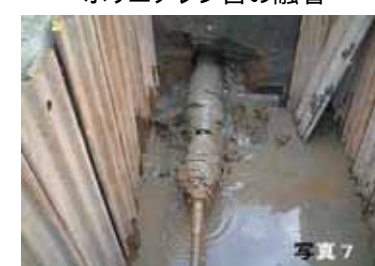
管の引き込み完了
