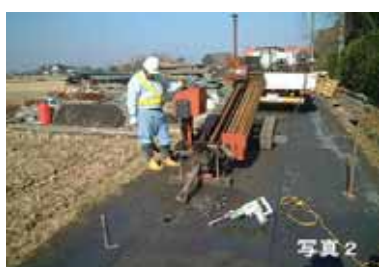
掘削機の設定
