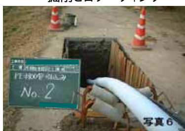
管の引き込み
