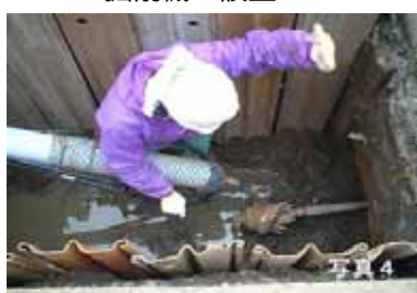
埋設管の接続
