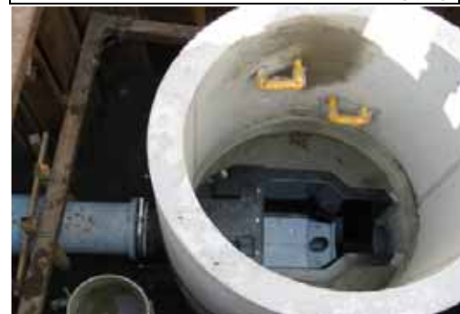
写真 2-2-2 減勢施設の施工状況
