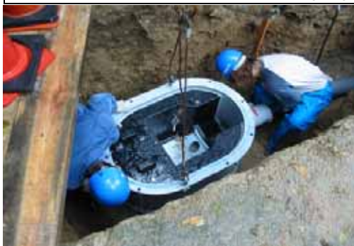
写真 2-2-2 減勢施設の施工状況
