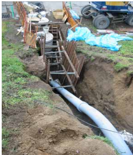
写真 2-2-1 急傾斜配管の施工状況
