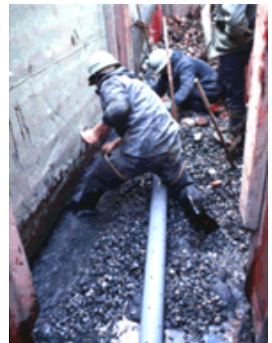
写真 2-1-1 湧水地盤での砕石基礎による施工
