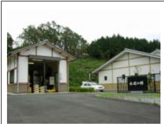
施設全景・汚泥処理設備(左側建物)
